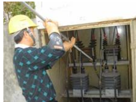
台中區處 PT 及 Power Cable 線上部分放電測試
