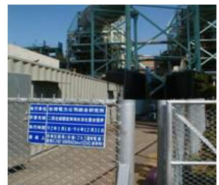
圖2、組裝於通霄電廠的實驗現場
