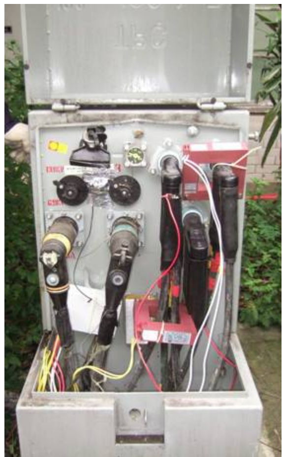
圖1. 變壓器感測記錄器施工完成圖
