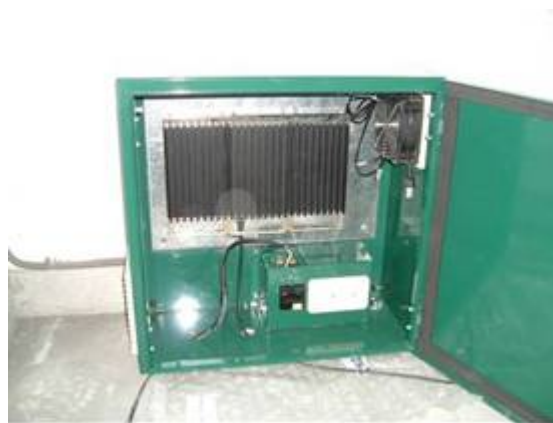
圖1、電力線通訊設備安裝實體圖
